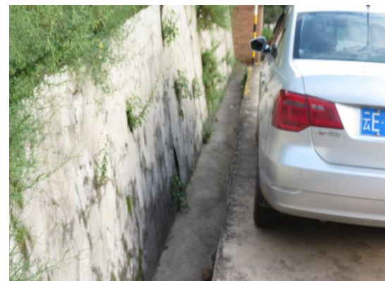
3#竖井工业场地截排水沟
