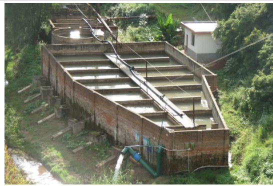
矿井涌水处理系统
