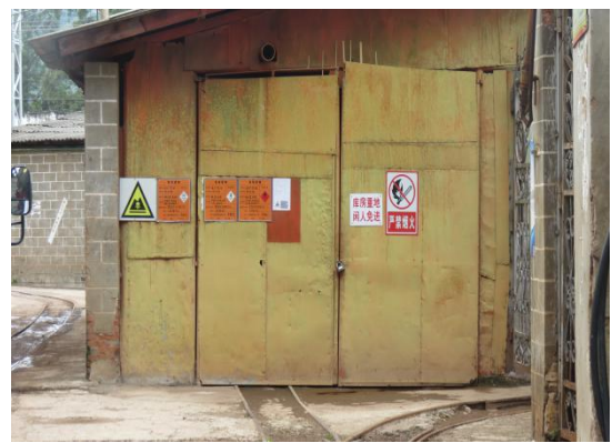
危险废物暂存间
