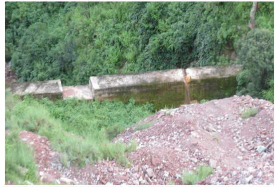
3#竖井废石场拦渣坝
